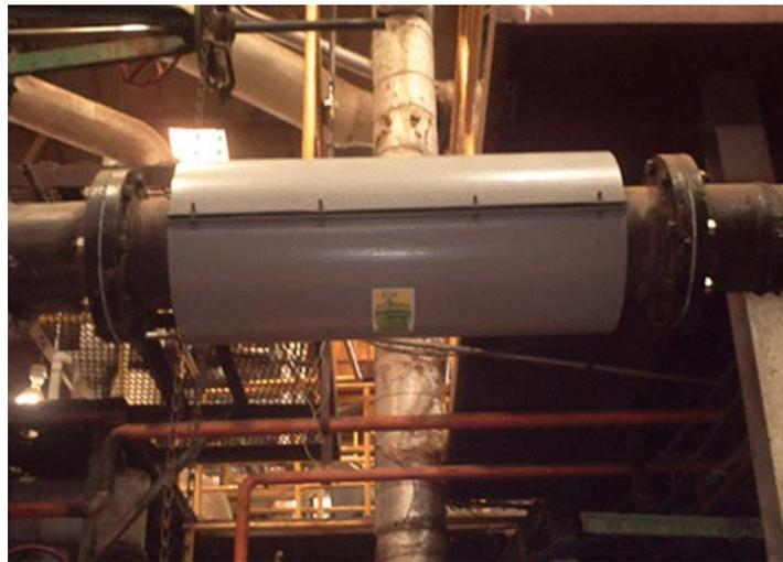
Figura 1. Esquema del diseño del magnetizador AZUMAG 8 y foto de la instalación.
