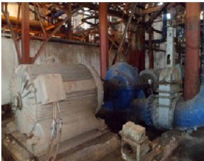
Figura 1. Instalación de bomba de inyección.
